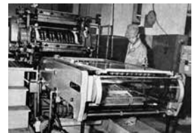
(図版) ドイツ製の番号印刷機「ヌメロータ」
