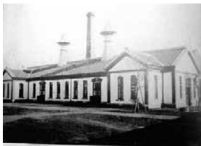
王子村に完成した抄紙部の建物
